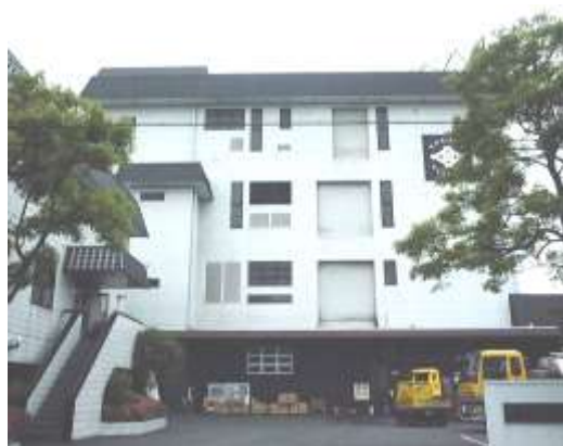
東京本社工場
